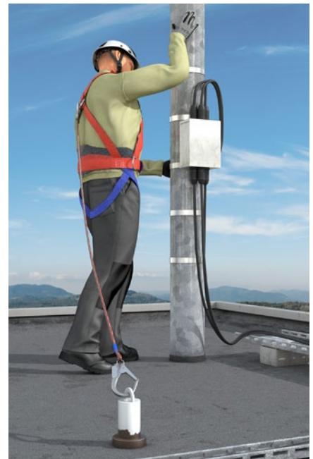
Abb. 17 Beispiel für ein Rückhaltesystem mit fester Länge
