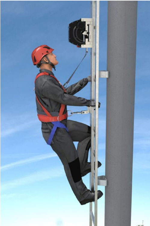
Abb. 48 Steigschutz ausgerüstet mit einer Steighilfe
