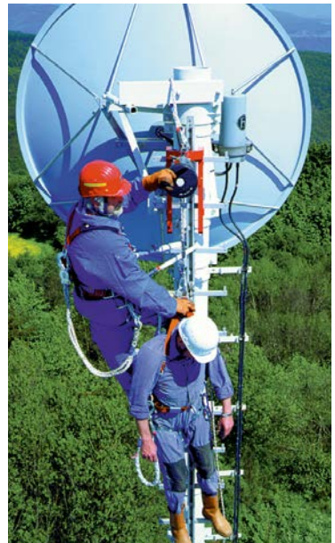
Abb. 8 Abseilgerät mit integrierter Hubeinrichtung
