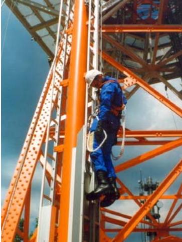
Person, die in einer Steigschutzeinrichtung hängt
