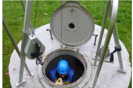
Abb. 23 Höhensicherungsgerät mit Rettungshubfunktion
