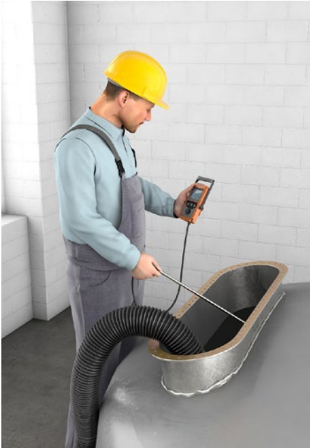
Abb. 19 Probenahme mittels Gasmessgerät
